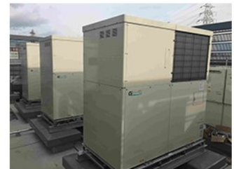
③マイクロコージェネレーションシステム (停電時対応型)
